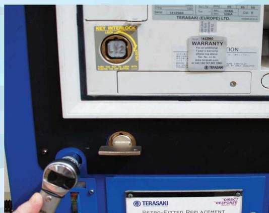
Los elementos funcionales extraíbles y los enclavamientos de seguridad de los mecanismos originales pueden conservarse y mejorarse. Incluso los mecanismos de tipo fija pueden ser reemplazados por un
