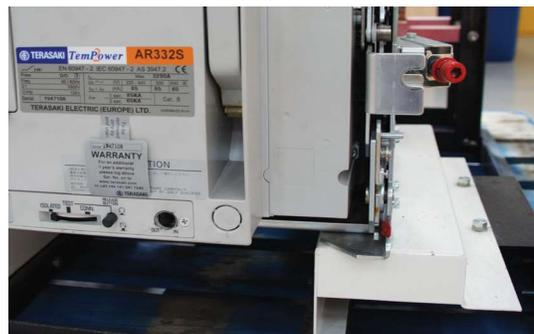
Los soportes de montaje son diseñados y fabricados a partir de las mediciones realizadas en la instalación para asegurar una integración mecánica perfecta. En la medida de lo posible, nuestros diseños tienen en consideración las ubicaciones originales de montaje en el cuadro, evitando así cortar y taladrar in situ.
