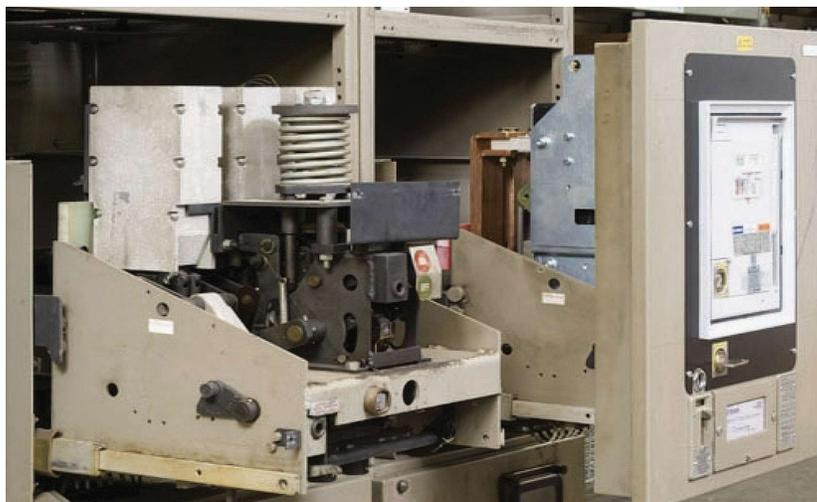
El retrofit se basa en la incorporación de nueva tecnología a sistemas antiguos. Los ACBs de retrofit pueden sustituir interruptores y disyuntores envejecidos e inseguros.
