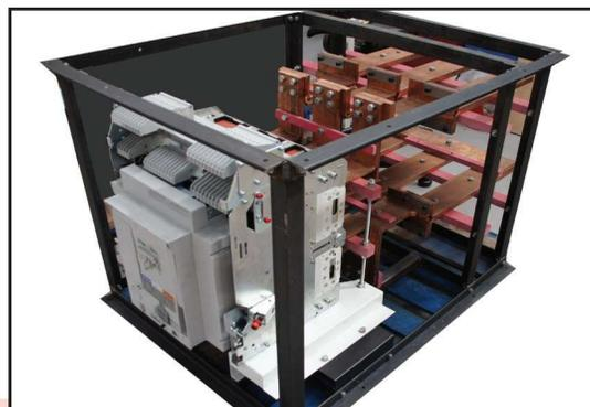
El embarrado de conexión se diseña mediante un software de evaluación del cortocircuito. Las pletinas de conexión eléctrica y los soportes pueden ensayarse según la Norma IEC 61439 (ensayo de resistencia de la pletina).
