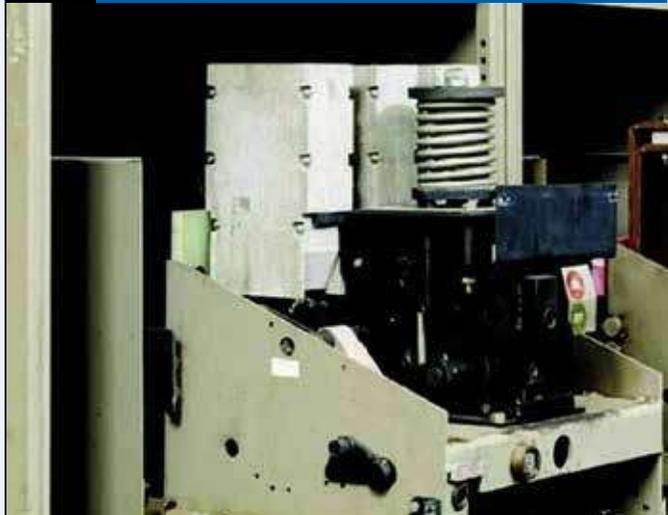
El retrofit se basa en la incorporación de nueva tecnología a sistemas antiguos. Los ACBs de retrofit pueden sustituir interruptores y disyuntores envejecidos e inseguros.
